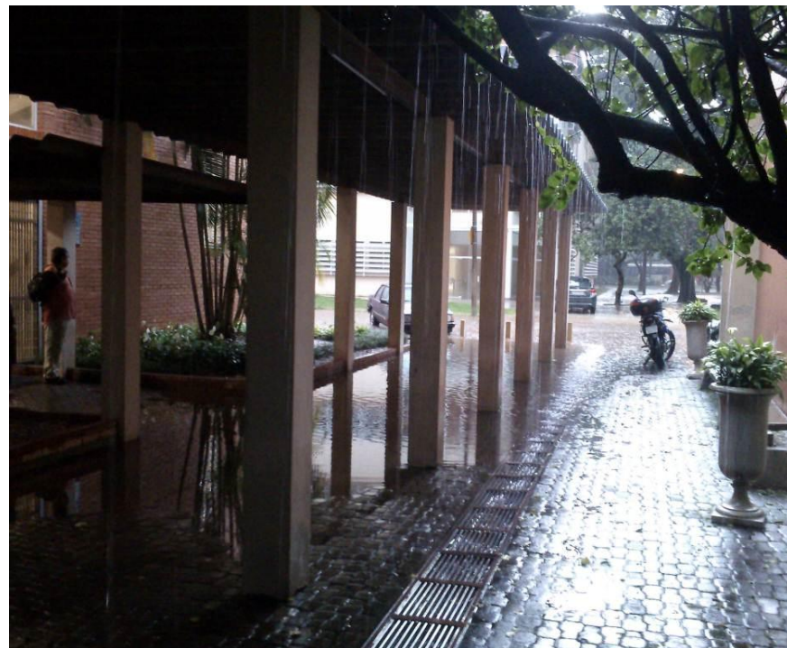
Portaria Bloco A
