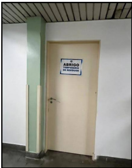
Imagem 98 Acesso a sala de resíduos - abrigo interno de resíduos perigosos
