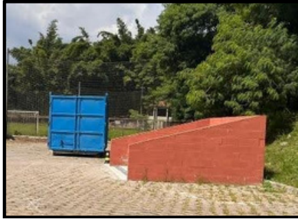
Imagem 13 Espaço para lavagem dos contêineres de coleta de resíduos comuns
