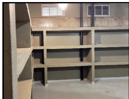
Imagem 70 Abrigo de RQ da FCF recém reformado
