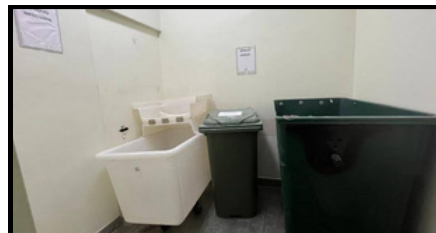
Imagem 100 Contêineres para recepção dos resíduos acondicionados em sacos de acordo com a tipologia
