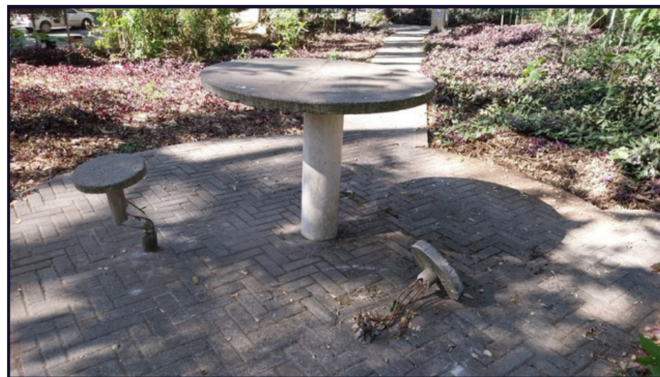
Figura 12. Banco com necessidade de manutenção (FFLCH) e banco isolado em estacionamento (FCF). Fonte: Acervo do GT
